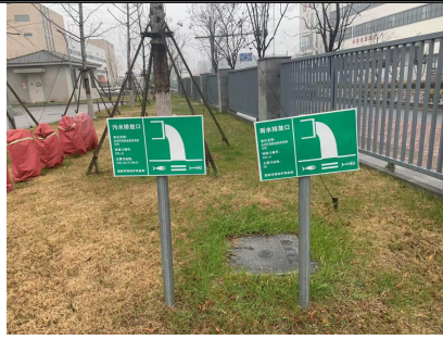
图 4-2 雨水污水排放口及标识牌图片
