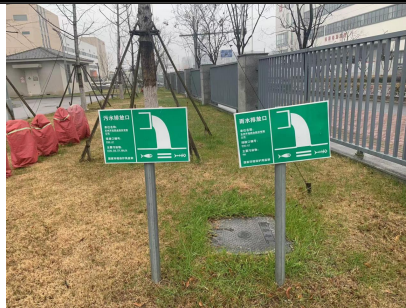
图 4-1 雨水污水排放口及标识牌图片
