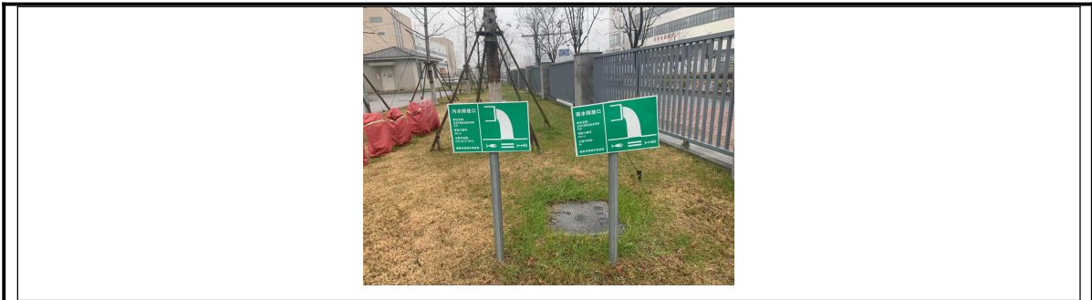
图 4-2 雨水污水排放口及标识牌图片
