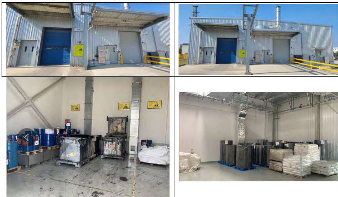
图 4-3 厂区危废仓库图
