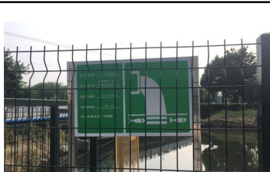
图 4-2 厂区雨水排出口
