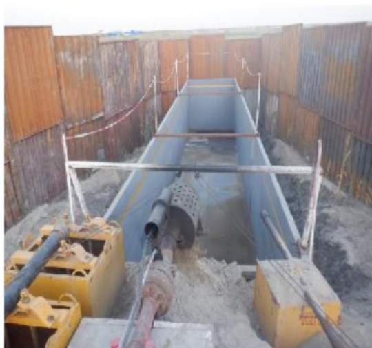
钻井期间井场设施
