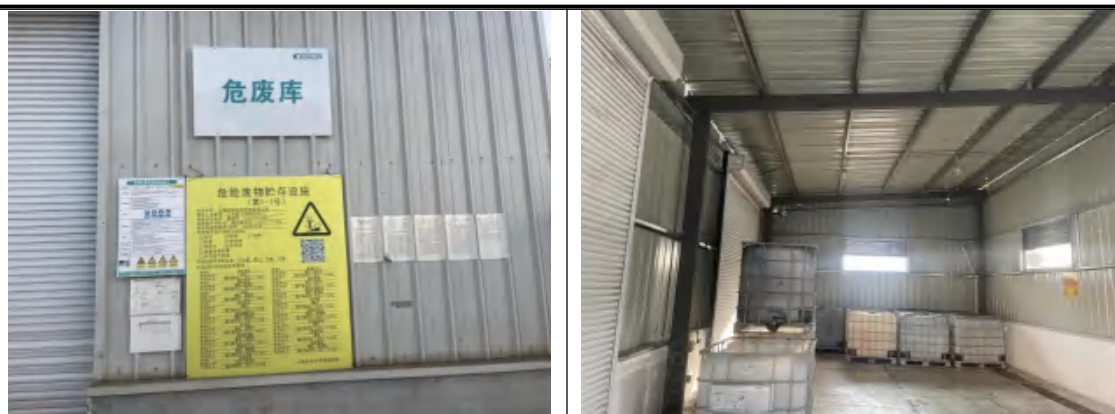
图 4-3 厂区危废仓库图
