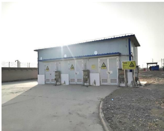
危废暂存库（正面）
