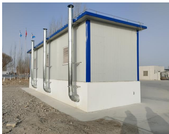
危废暂存库（侧面）
