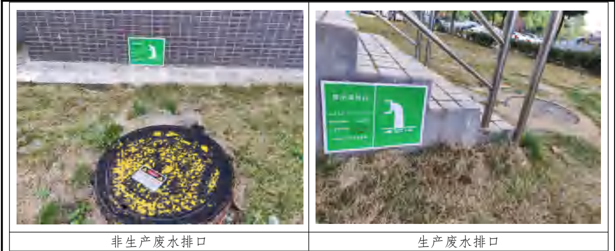
图 4-2 废水排口照片
