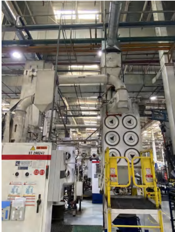
喷丸滤筒除尘器
