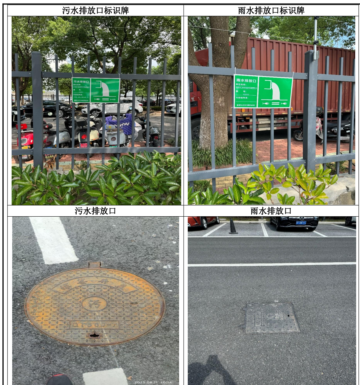
图 4-2 废水处理设施及标识牌
