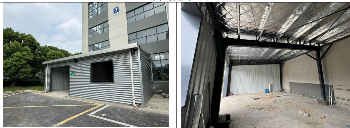
图 4-6 危废仓库和一般固废仓库现场图片
