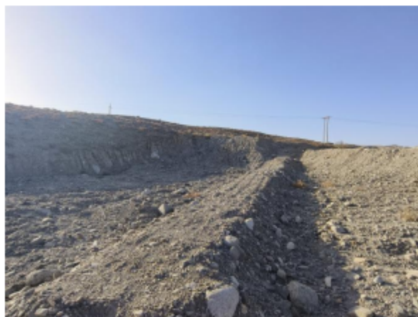
管线施工恢复
