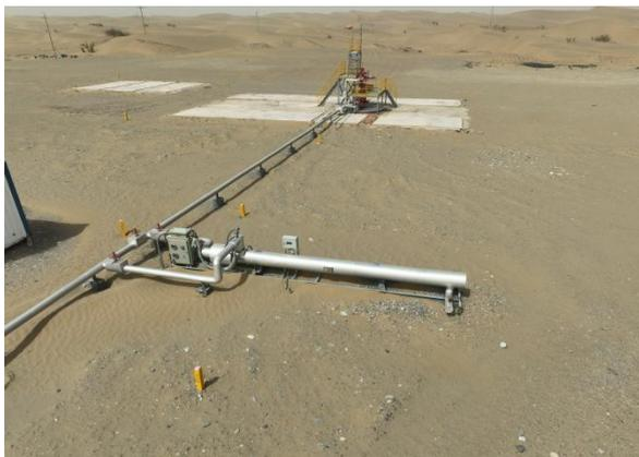
ZG29-H8 井电磁加热炉
