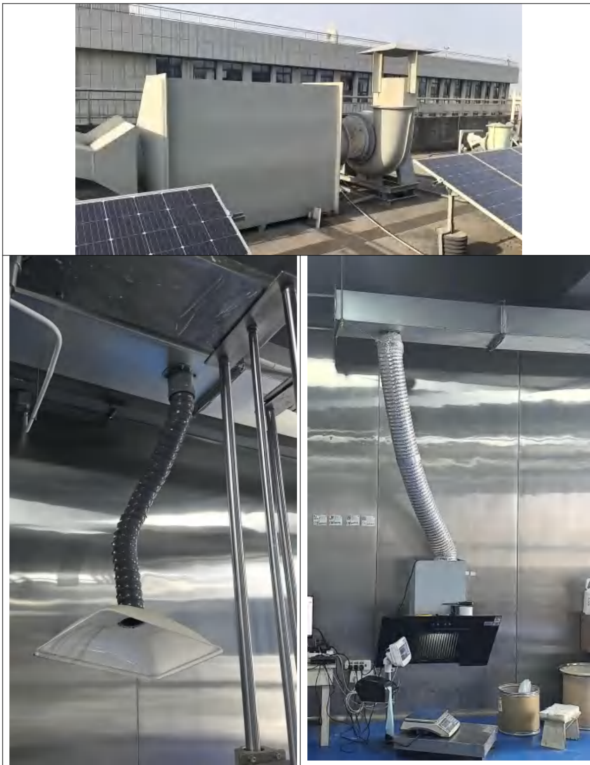
图 4-4 废气处理现场图
