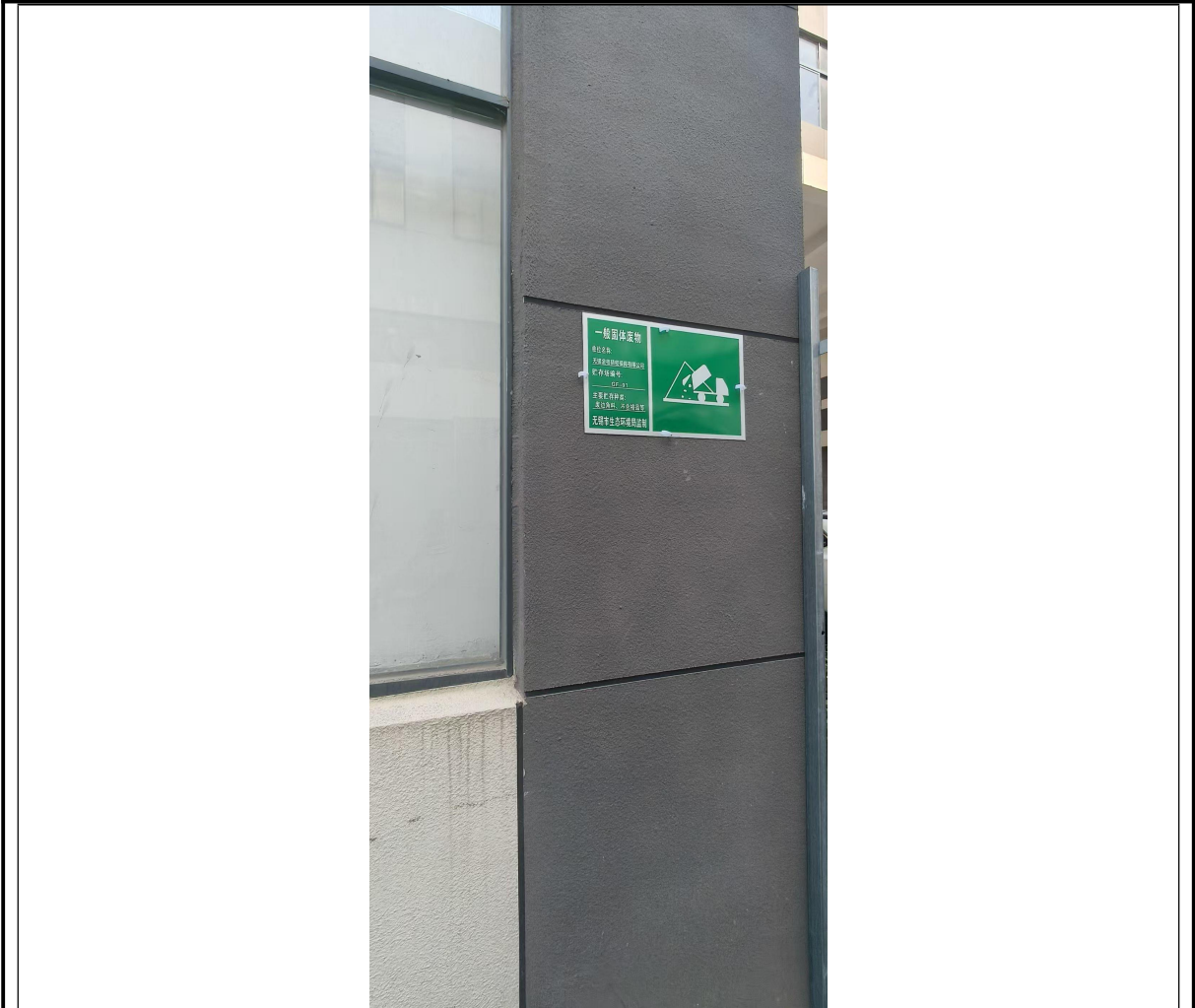
图 4-4 一般固废仓库现场照片
