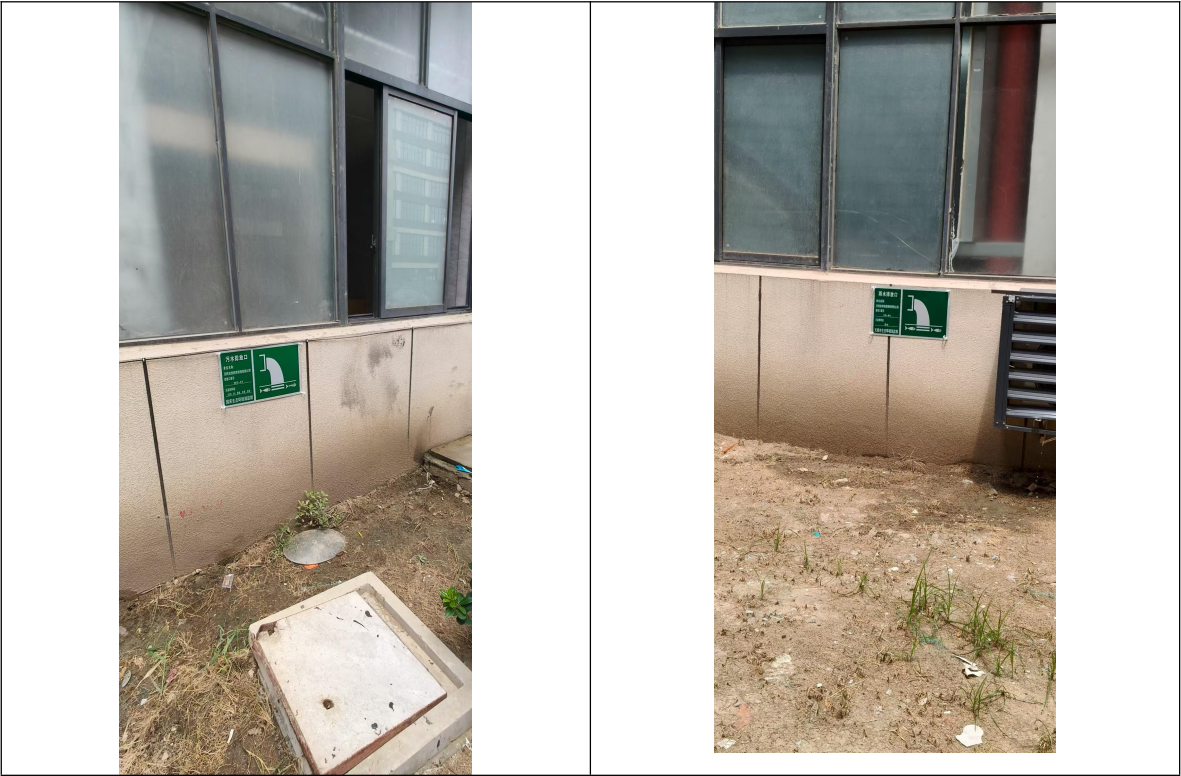
图 4-2 雨水和废水排口及标识牌
