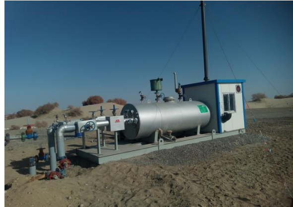
TH10451X 井同型号加热炉（100kW）
