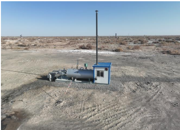
100kW 加热炉
