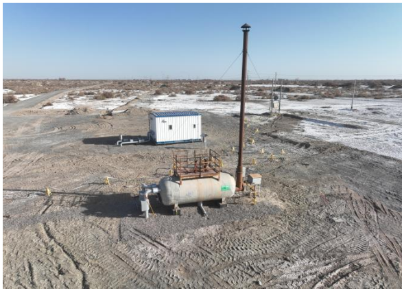
200kW 加热炉
