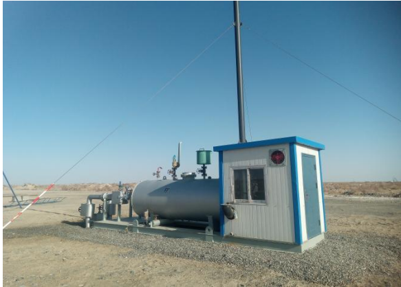
TH10154X 井加热炉（100kW）
