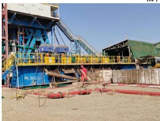
泥浆不落地系统
