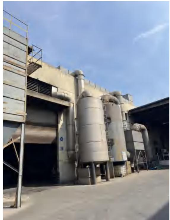
熔化、除气工序水喷淋/水喷淋+布袋除尘
