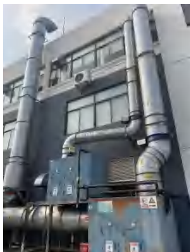
图 4-2 废气处理设施及排气筒现场照片
