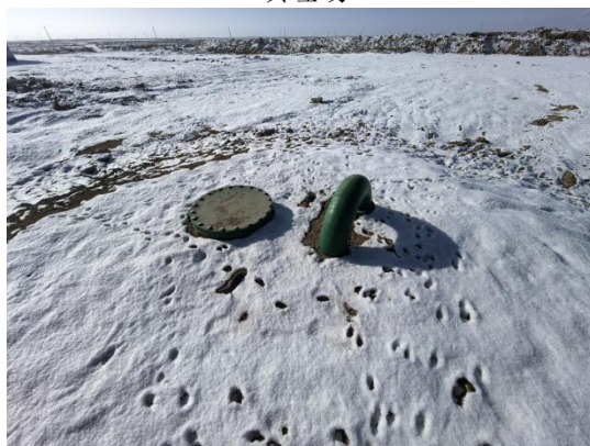
渗滤液收集池
