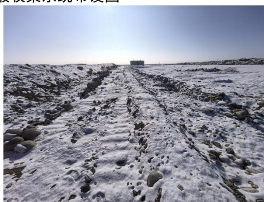
渗滤液导排管道
