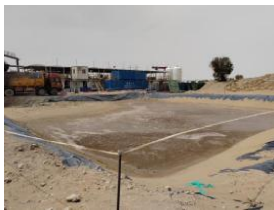
防渗岩屑暂存池
