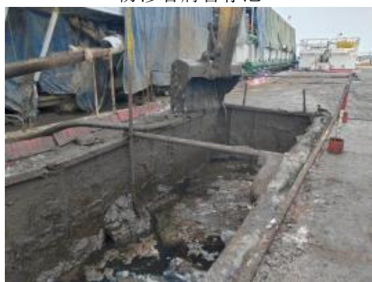
泥浆不落地系统
