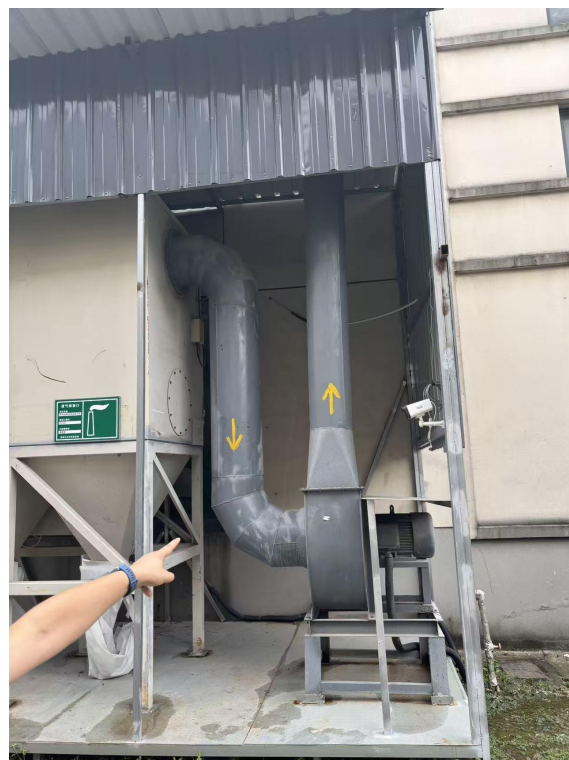
图 4-3 废气处理及排放流程（附“◎”有组织废气监测点位示意图）
