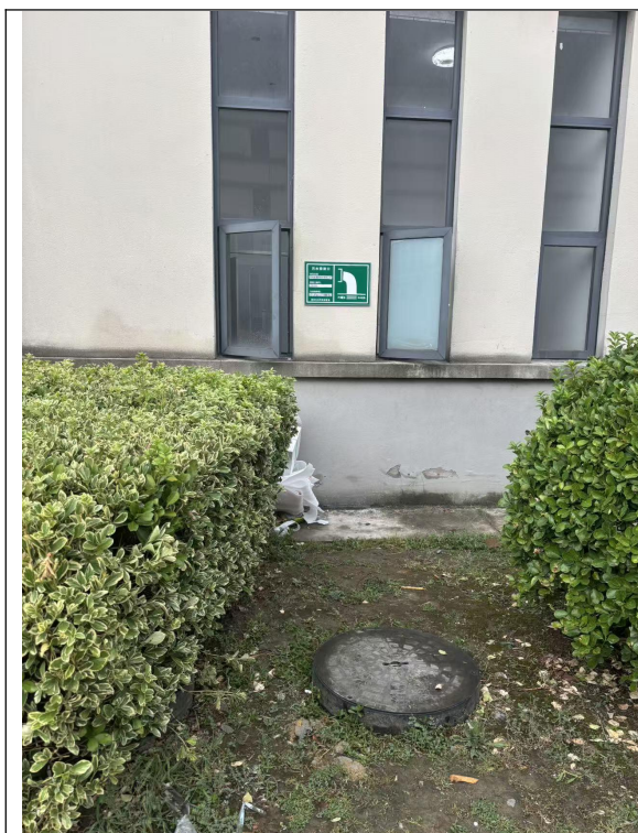
图 4-1 污水排放口及标识牌照片
