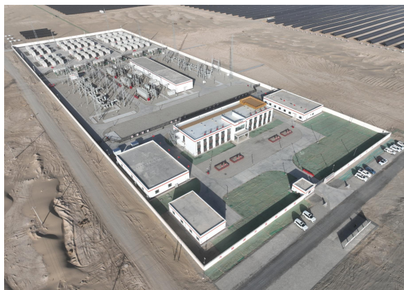
1# 升压站+储能区
