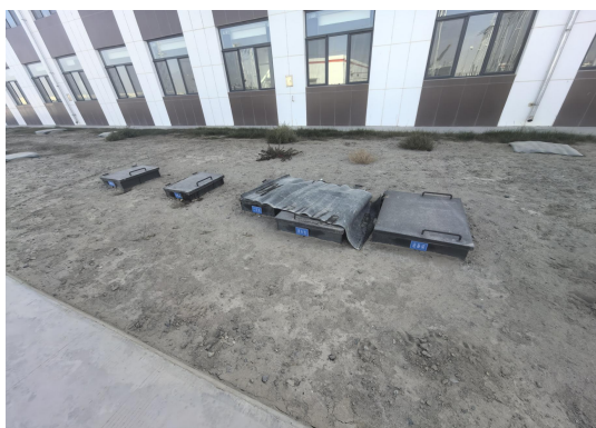
地埋式一体化生活污水处理设施
