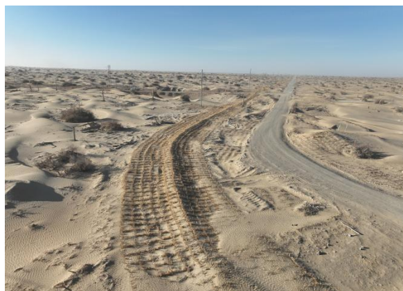
富源 601 井管线恢复及草方格
