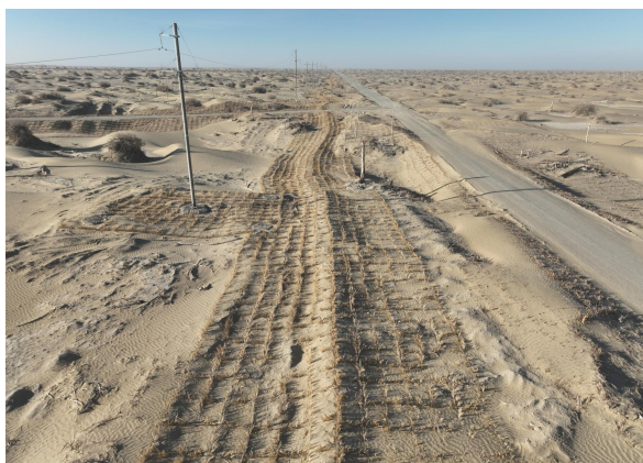
富源 601 井管线恢复及草方格
